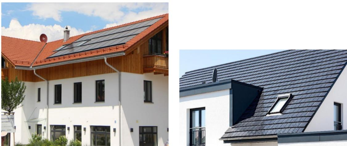
Abbildung 5-6: Beispiele für eine dachintegrierte PV-Anlage in Dürnbach (links) und Solardachziegel (<https://www.autarq.com>) (rechts).
